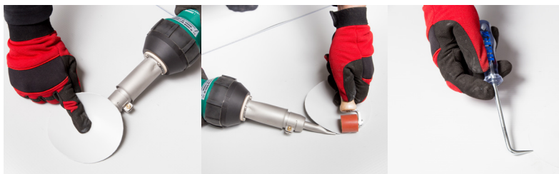
Рисунок 16.2. Установка заплатки
