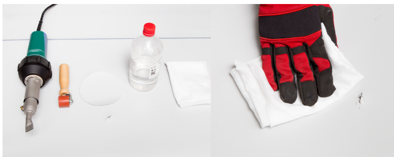
Рисунок 16.1. Подготовка поверхности мембраны
