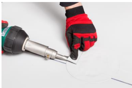
Рисунок 69. Последовательность проверки сварного шва, выполненного автоматическим оборудованием
