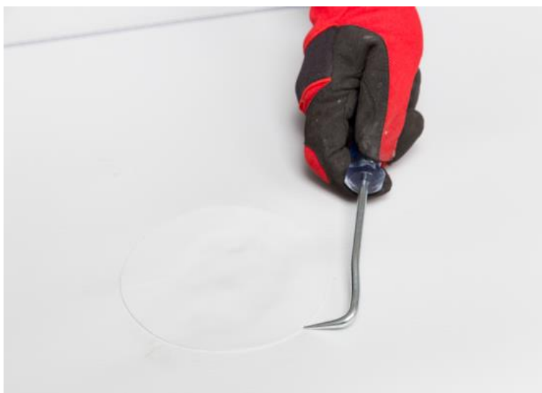
Рисунок 70. Проверка сварного соединения экстрактором шва
